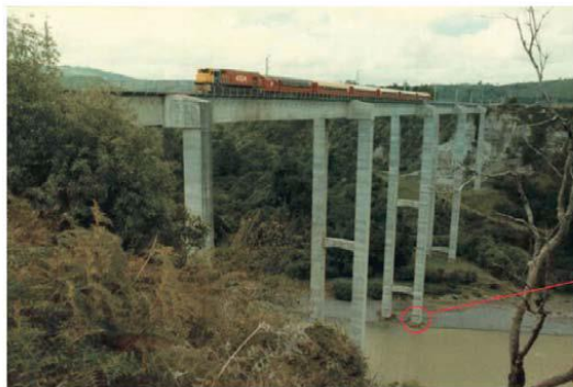
شکل ۲: کاربرد حرکت گهواره ای و وسایل مستهلک کننده انرژی در پایه پل راه آهن رانجیتیکی جنوبی (Cornak, 1998)
