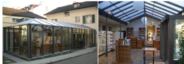
شکل 2- کاربرد پنجره با شیشه ایروژلی مات در سقف یک داروخانه در سوئیس (Saffa B. Riffat, Guoquan,2013).
